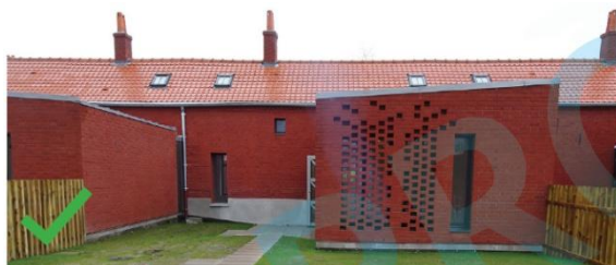
Extension réalisées par J. Didelon cité des Électriciens
