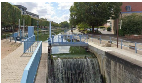
Figure 34 : L'écluse des Augustins à Douai, Août 2020 – Source : Google maps
